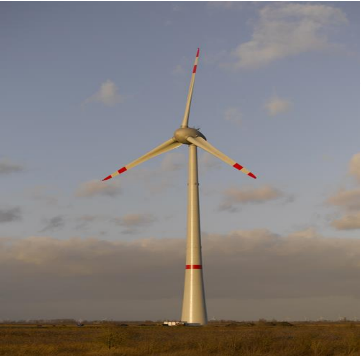
Enercon E126, 7.5MW, 126 diameter
